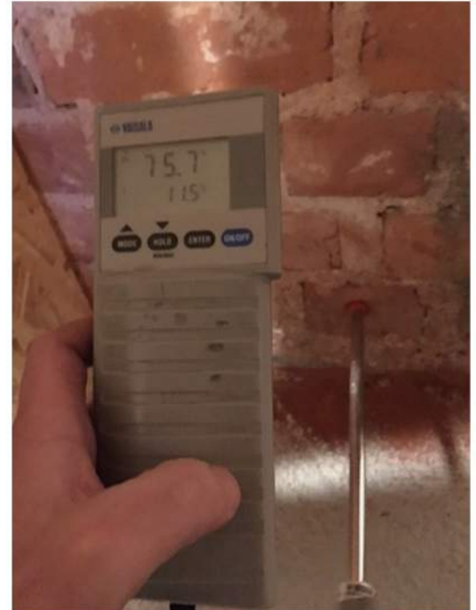
En av mange fuktmålinger utført på etterkontroll og oppfølging av fuktforhold. Målt RF på 75%, noe som er "tørt" (akseptable fuktverdier).
