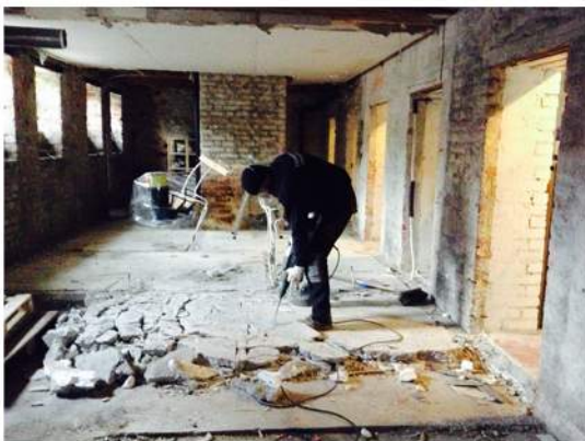
Fjerning av betonggulv i dårlig forfatning. Elektrosmose legges i ny støp.
