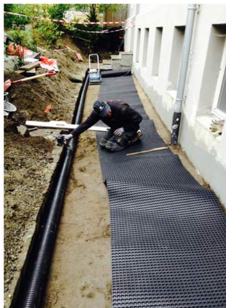
Overflatedrenering en yttervegg, bakgård.
