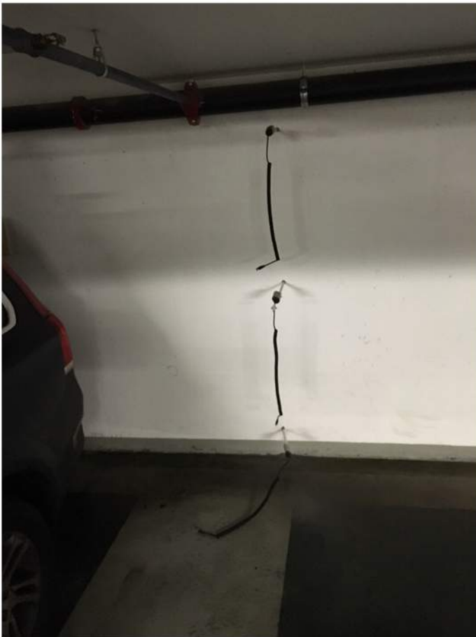
Metodisk fuktmåling av all kjellerkonstruksjon. RF-måling med fuktprober i ulik dybde og høyde på vegg.
