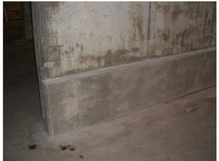
Etter støp og fuksikring.
