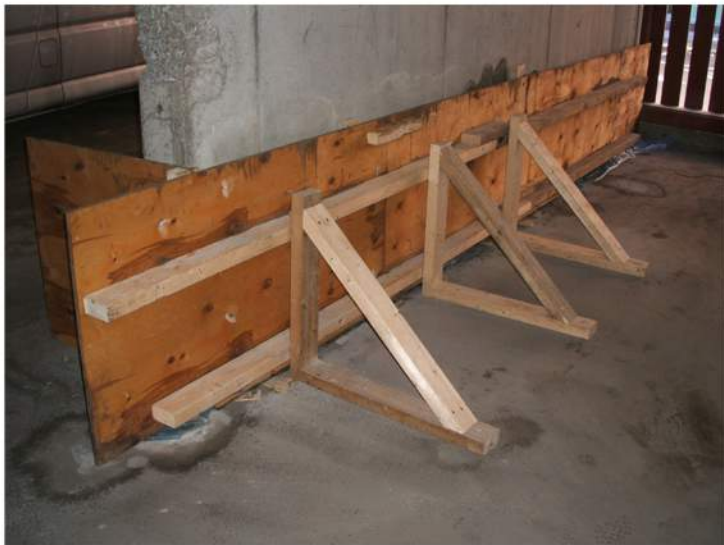
Forskalling av vegg, etter rehabilitering av skadde armeringsjern. Det ble også installert elektroosmose.
