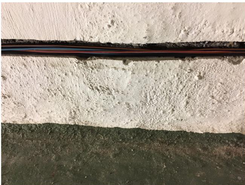
Installasjon av en langsgående elektroderad i all veggkonstruksjon.
