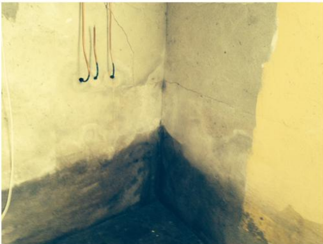
Konstruksjon fuktmettet nederst i hjørnet. Visuelt tegn på fuktmetning, samt målt RF på 100%.
